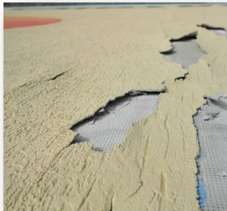
Uszkodzenia mechaniczne
