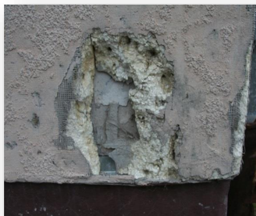
Uszkodzenia mechaniczne
