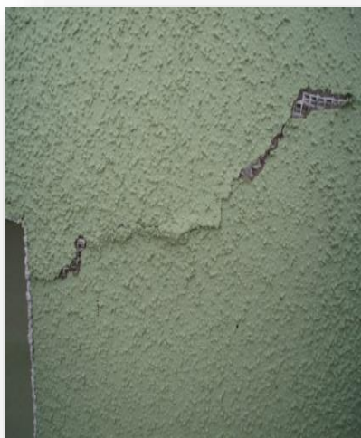
Pękanie i osypywanie się warstw zewnętrznych ocieplenia
