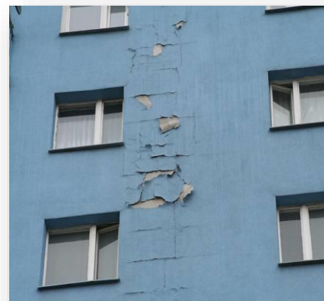
Uszkodzenia mechaniczne
