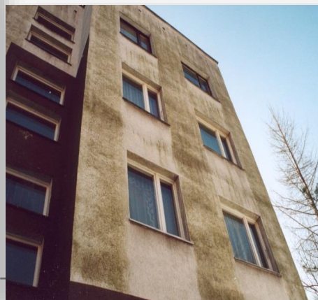
Skażenie mikrobiologiczne na elewacjach
