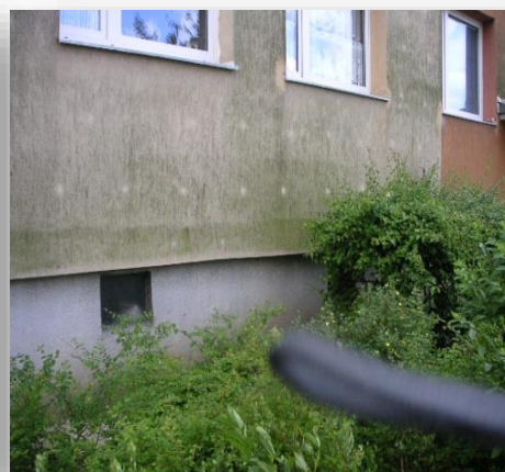
Skażenie mikrobiologiczne na elewacjach
