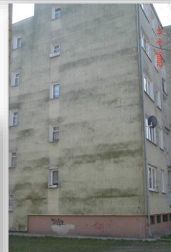
Skażenie mikrobiologiczne na elewacjach
