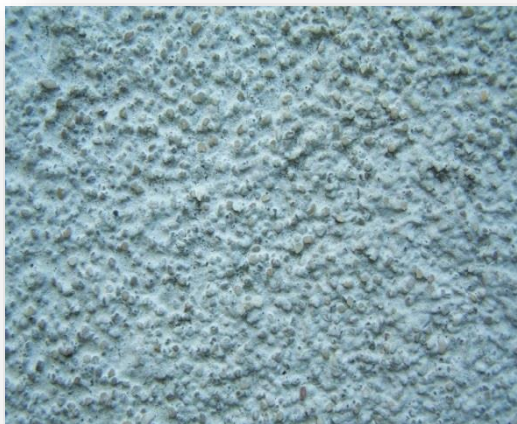
Pękanie i osypywanie się warstw zewnętrznych ocieplenia
